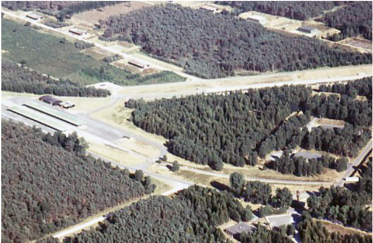
Abbildung 69 Bahnhof I und ein Teil der Laderampe Nord von Westen her gesehen. Rechts die Labs. Aufnahme ca. 1994. (laho09)
