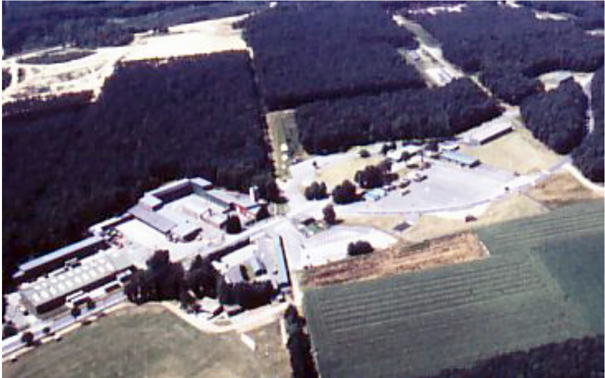
Abbildung 52 Vor und hinter dem Depotzaun liegende Teile des Depots im Bereich des Zugangs von der St. Barbara-Straße aus. Blickrichtung nach Westen. Aufnahme ca. Herbst 1995. (laho37)
