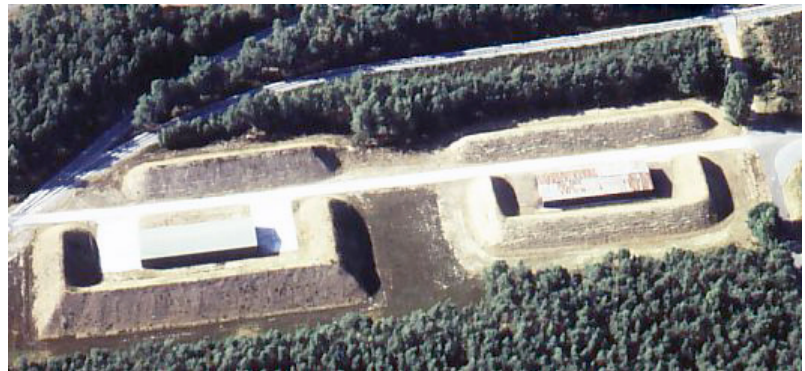
Abbildung 60 Munitionshallen nahe am Bahnhof III. Man erkennt deutlich das Sicherungskonzept mit den unterschiedlich dimensionierten Schutzwällen. Demnach lag in der linken Halle brisanteres Material als in der rechten Halle. Die Schutzwälle waren sorgfältigst von jedem höheren Bewuchs freigehalten. Aufnahme von ca. 1994. (laho26)
