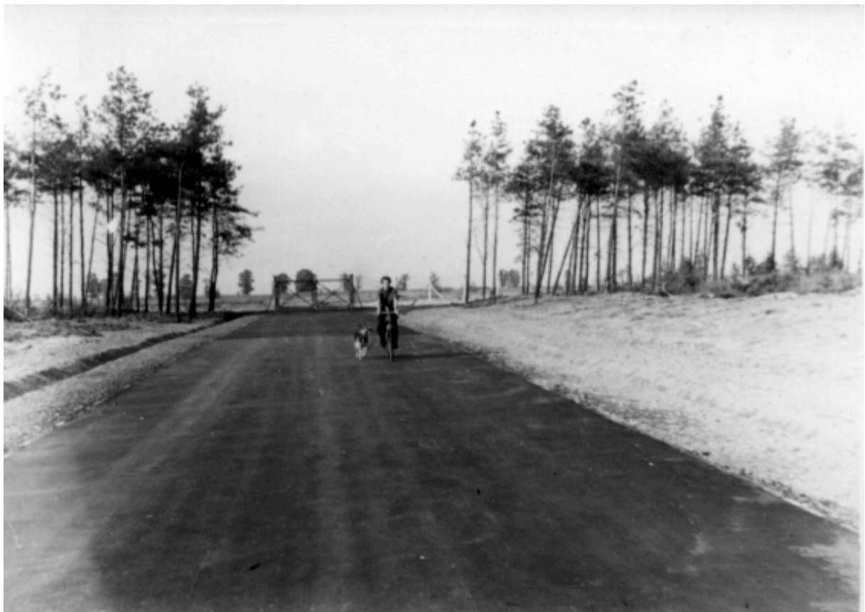
Abbildung 32 Blick von Süden auf das ehemalige Gate 8. Aufnahme ca. 1952/53. An dem dunkleren Bodenbelag ist die Stelle zu erkennen, wo bei der Bekämpfungsaktion gegen Maikäfer der Hubschrauber landete und (aggressives) Spritzmittel nachtankte. (audy22.bmp)
