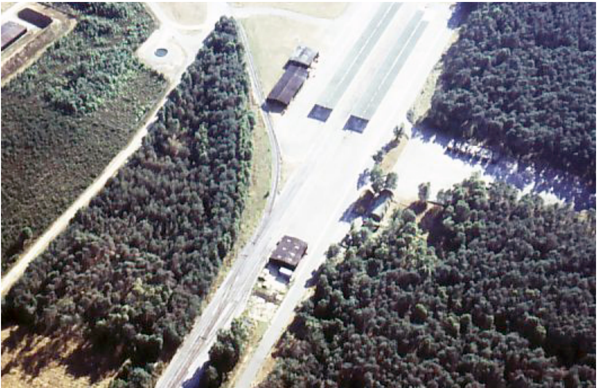
Abbildung 70 Bahnhof I etwa aus Richtung Nordwesten. Rechts der Laderampen verläuft der Roermonder Weg. Aufnahme ca. 1994. (laho11)
