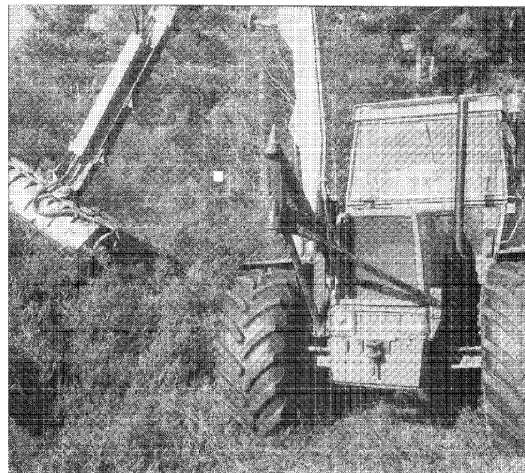
Mit einem Spezialmäher werden die Heide-Büsche geschnitten. Um bei der Arbeit an den Splitterschutzwällen mit dem Fahrzeug nicht umzukippen, sind die Reifen zu Zweidrittel mit Wasser gefüllt. Foto: hosi
