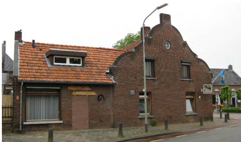
Afb. 3.24 Pand aan het begin van de St. Antoniusstraat
