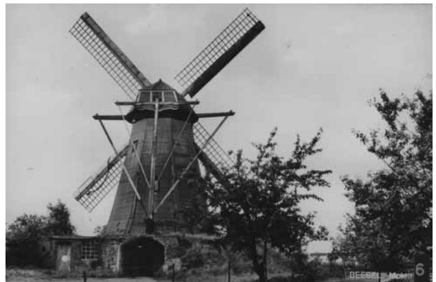
De molen met links in de onderbouw aangebouwde machinekamer en wc. De invaart met poort achterin.
