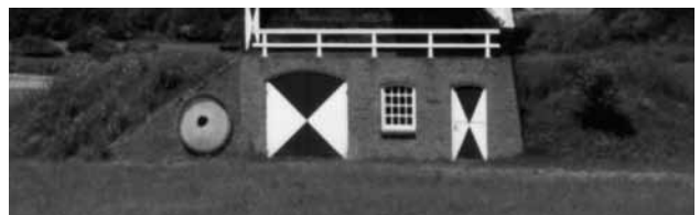
De onderbouw na de herbouw in het Kerkveld.
